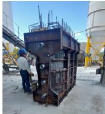
SECCIÓN DE VIGA POSTENSADA CON FORMALETA PARA FUNDIR
