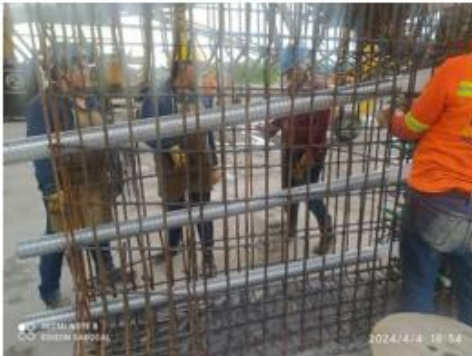
ARAMIDO ACERO E INSTALACIÓN DE DUCTOS VIGA POSTENSADA
