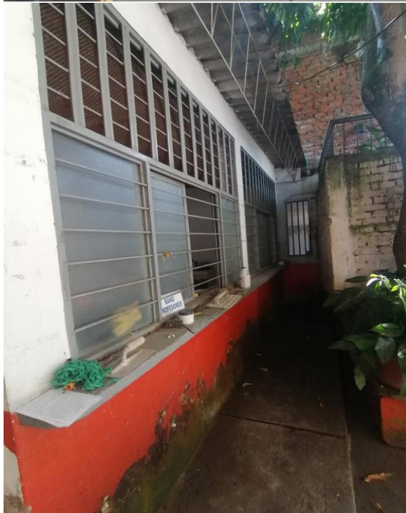
Actividad: Reparación Restaurante Escolar. Lugar: sede Santa Cecilia.
