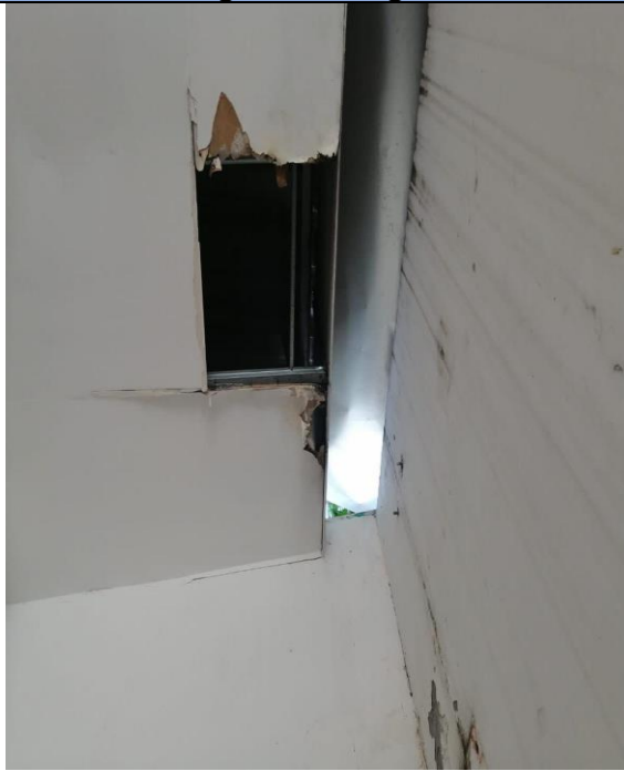
Actividad: Reparación Cielo Raso. Lugar: sede Santa Cecilia.
