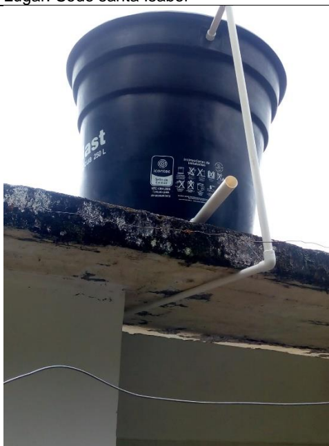
Actividad: instalación tanque de reserva Lugar: sede pablo VI
