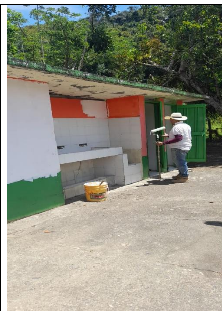
Actividad: mantenimiento baños (pintura, cambio baterías)
