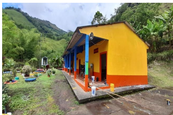
Actividad: mantenimiento pintura
