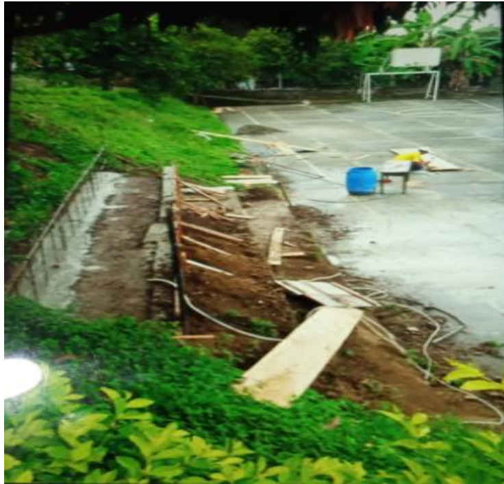
Actividad: Mantenimiento y Reparación locativa Lugar: Sede Manuela Beltrán
