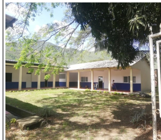
Actividad: construcción de cubierta de techo
